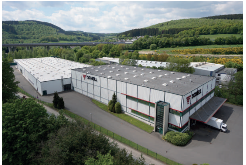
Závod 2 Výrobná hala s logistickým centrom
